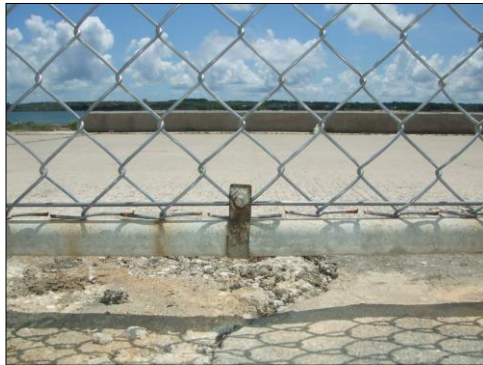
合成樹脂被覆線:設置後約7年
