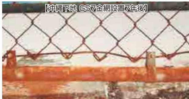
金網の腐食が激しく胴縁ももらいサビが起きている。
