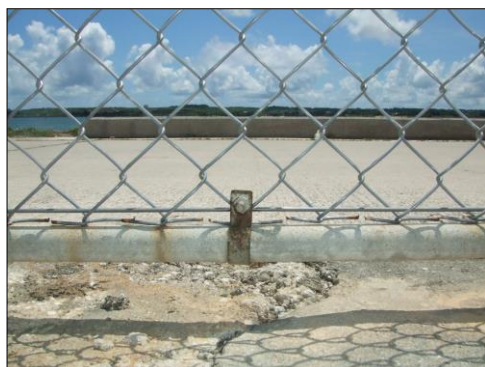
合成樹脂被覆線:設置後約7年
