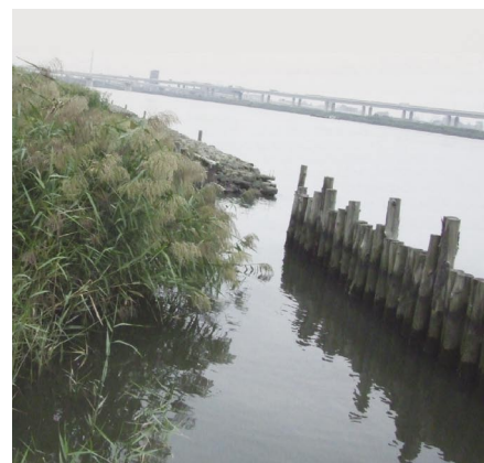
施工後堆積した腐植土で覆われた箇所の適用例
