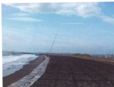
トワロン IR被覆鉄線の構造(写真上)と 施工例(護岸用かごマット、千葉県)
