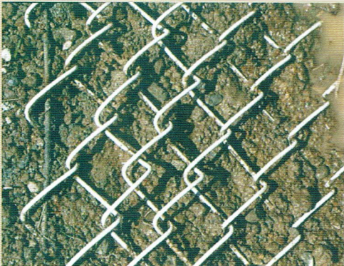
IR(低密度ポリエチレン)被覆亜鉛めっき鉄線 設置後約 8 年経過 ツヤもあり設置当初の状態を維持している。
