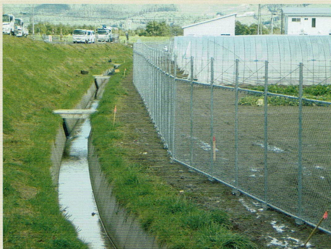
富良野市 (H28 年度施工)
