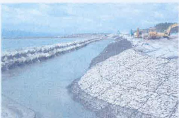
『トワロンIR被覆鉄線』は、高品質の低密度ポリエチレン樹脂と心線材の亜鉛めっき鉄線を完全接着させることにより、空気・水分を遮断して心線材を保護し、耐久性を飛躍的に向上させた線材です。
