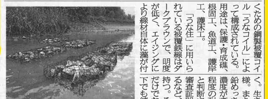
「うな住」は、トワロン製のIR被覆亜鉛めっき鉄線(心線はめっき線、被覆厚0.5mm)を用いた強化かごマットと、藻類の生長を促し、ニホンウナギの餌となる甲殻類を導く効果が確認されているアミノ酸入りプロック「うなパネル」と、ニホンウナギが住み着くための鋼製被覆コイル「うなコイル」によって構成されている。用途は、保護育成礁、根固工、魚道工、護岸工、護床工。
