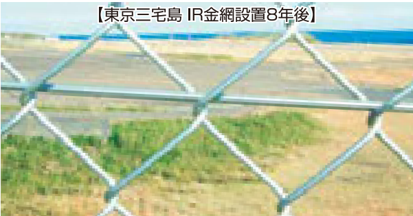
【東京三宅島 IR金網設置8年後】 二酸化硫黄 (SO 2 ) の放出量が鹿児島県の桜島の活発な活動期と同程度 (平均2.885t/日) の環境下で、設置後8年でも変化なし。 ※ 三宅島火山防災連絡事務所の観測データによる。
