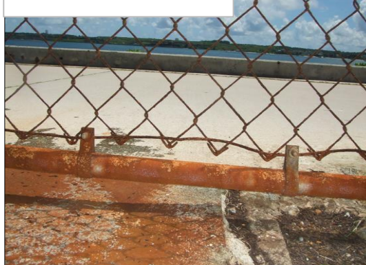
GS7金網 施工後約7年
