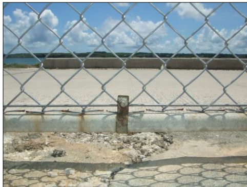
合成樹脂被覆線:設置後約7年
