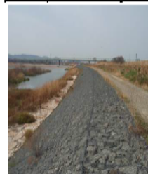
左写真： 鉄線籠型護岸
