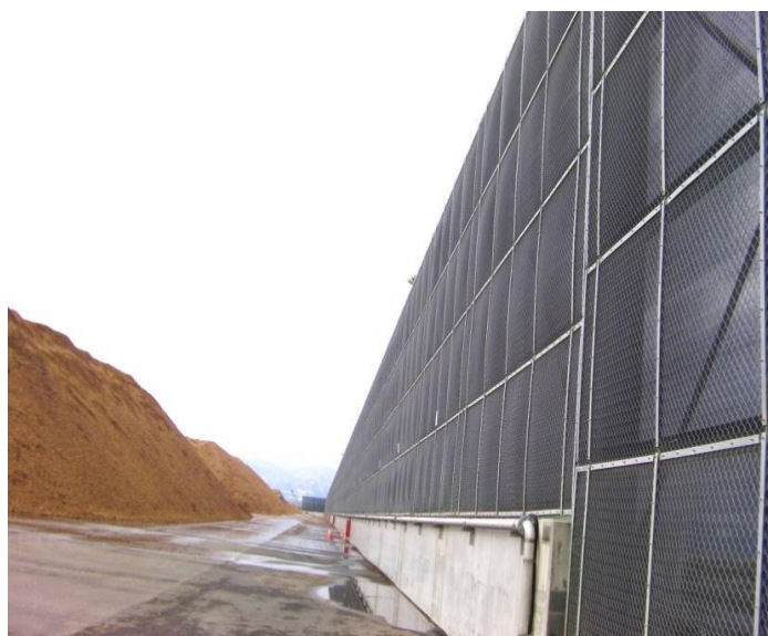
北海道 チップヤード 飛散防止網
