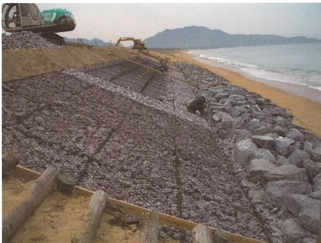
写真4 福岡県北九州 2006 (緩傾斜堤)
