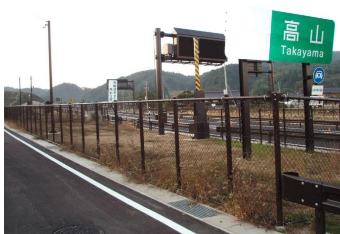
岐阜県 立入防止柵
