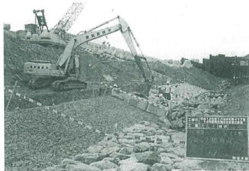
写真-5.1 裏込めにかごマットを用いた施工例 (宮崎住吉海岸)
