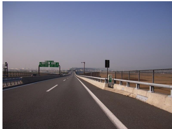
京都府 落下物防止柵
