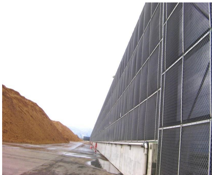
北海道 チップヤード 飛散防止網
