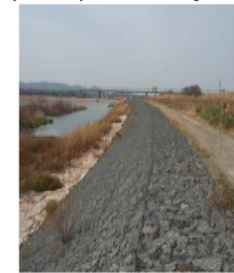
左写真： 鉄線籠型護岸
