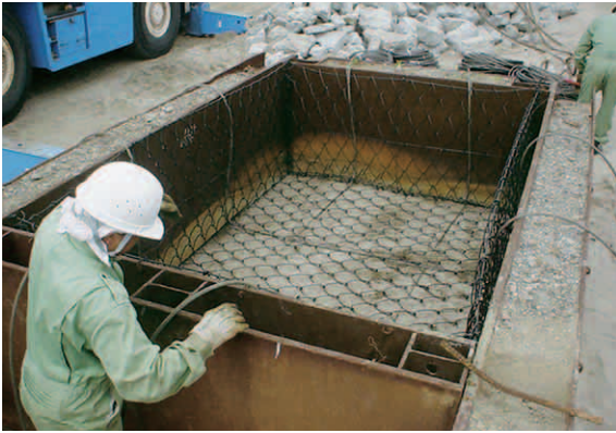
① 組立・型枠設置
