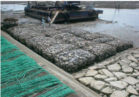
④ 敷設完了
