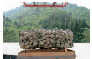
⑥吊り上げ・転置
