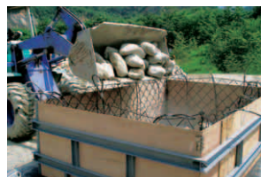
④中詰材の投入
