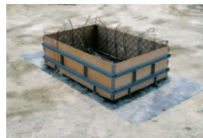
③型枠の取付
