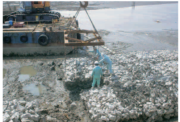
③ 据付け（吊り施工）
