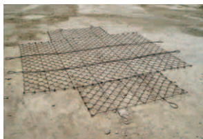
①金網パネルとワイヤロープの取付
