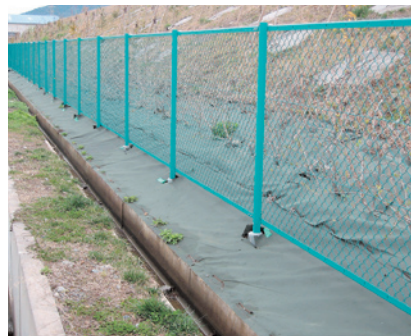
第二東名高速道路 金谷地区 立入防止柵工事
