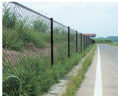
首都圏中央連絡自動車道 木更津舗装工事
