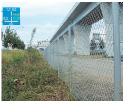
中部横断自動車道 増穂舗装工事
