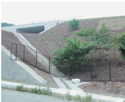
第二東名高速道路 倉真地区 立入防止柵設置工事
